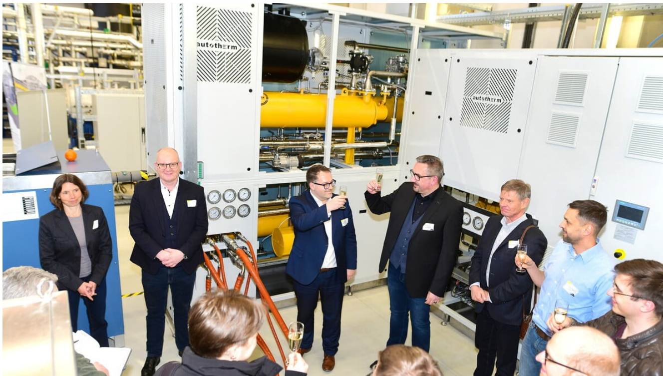
Die neue Testanlage für Wärmespeicher im Kraftwerkslabor der Zittauer Hochschule ist jetzt eingeweiht. © Matthias Weber/photoweber.de
